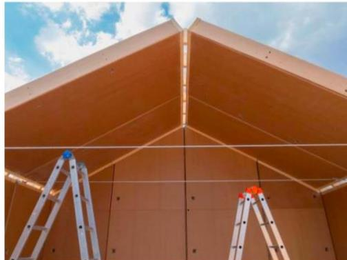
Le strutture in cartone, sicure e sostenibili, si smontano e si spostano con facilità. Anche per questo motivo la T-Box punta a ridefinire l'architettura di "emergenza" e le verifiche serviranno proprio a validare questa tesi.
